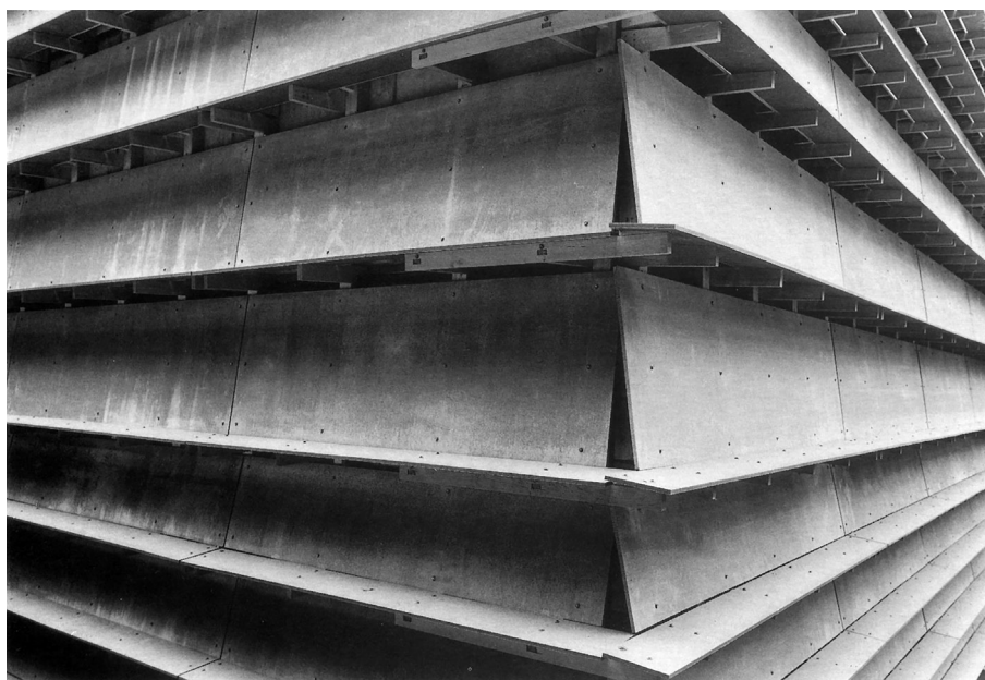
Fig. 9. Vista ravvicinata di una delle “invenzioni tettoniche” proposte con il progetto per il Magazzino Ricola di Leufen, in Svizzera, da Herzog & De Meuron, che conferiscono forma plastica a materiali sottili variandone geometria e configurazione delle tradizionali strutture di posa, in questo caso di pannelli di fibrocemento (foto concessa da Il Giornale dell’ Architettura ).
