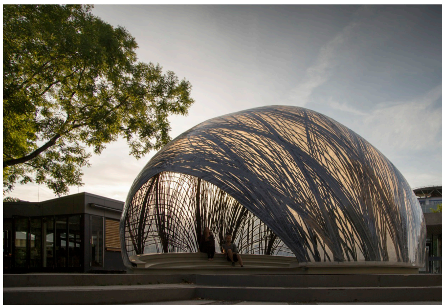
Fig. 10. Padiglione del gruppo di ricerca e laboratorio ITKE di Stoccarda 2014/2015 realizzato con tecniche robotizzate per la posa della fibra di carbonio, modificate ad hoc per la realizzazione sul posto della struttura (foto concessa da Laboratorio ITKE).
