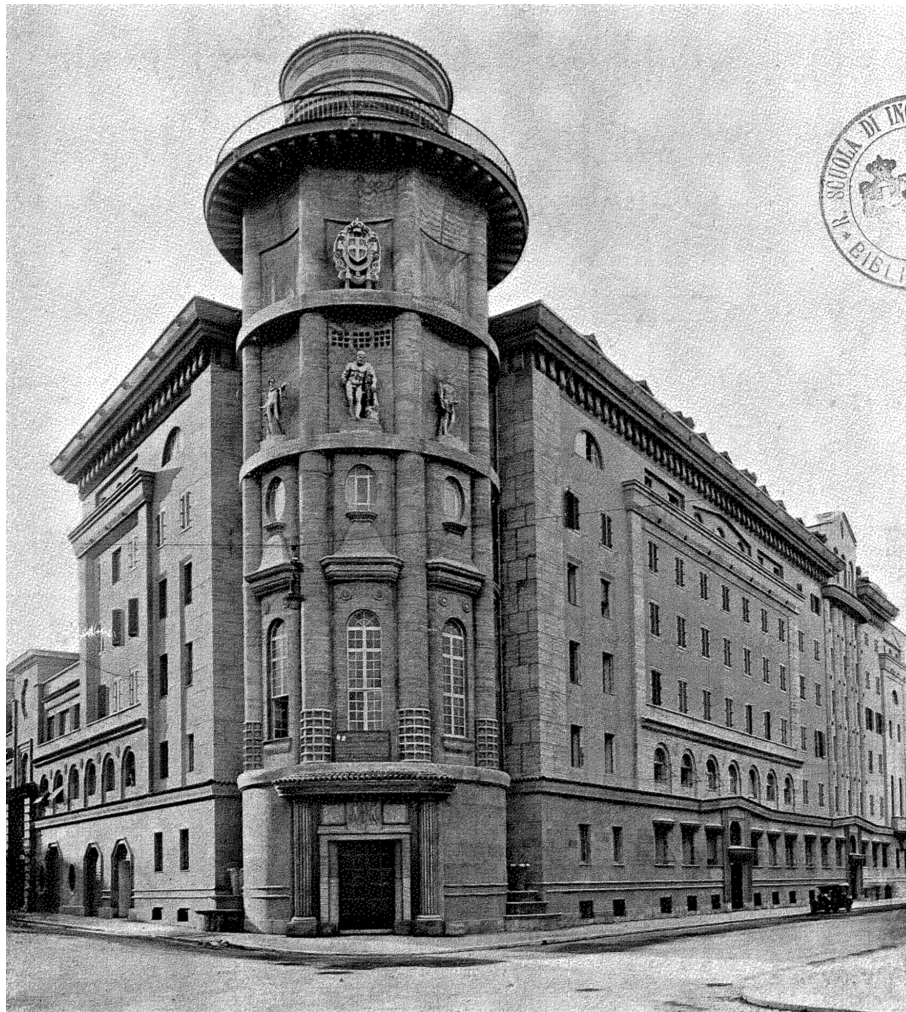
Fig. 4. Roma, Autoparco del Ministero degli Interni (AUTOPARCO 1931, immagine di copertina).
