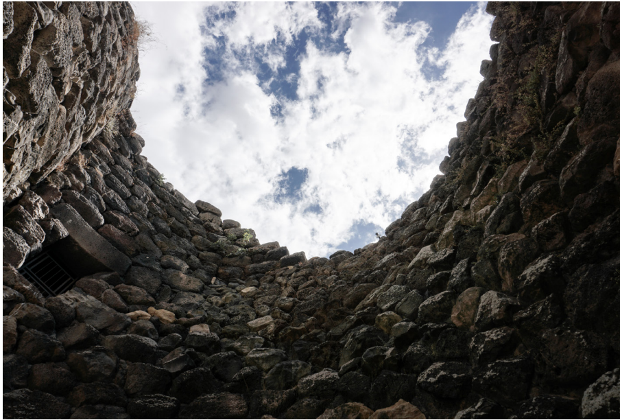
Fig. 6. Barumini, Su Nuraxi, dettaglio dal cortile (foto dell'A.).
